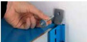
Per il fissaggio a parete è obbligatorio utilizzare un tassello per ogni fiancata con un valore di trazione (compreso il coefficiente di sicurezza) pari a **1,3 Kn**.
